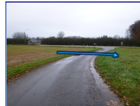
Traversée de la route d'Allouville de l'axe T2
