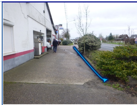
Ecoulements dirigés vers l'avaloir à côté du garage
