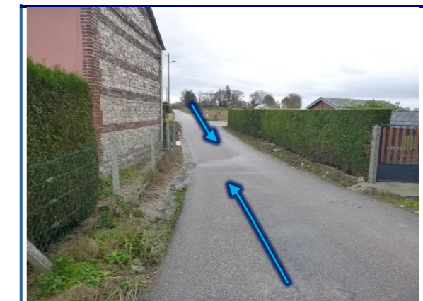
Inondation de la rue de Bellefosse lors de fortes pluies
