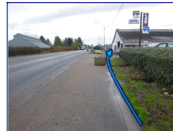
Arrivée des eaux de la voirie à l'entrée du garage
