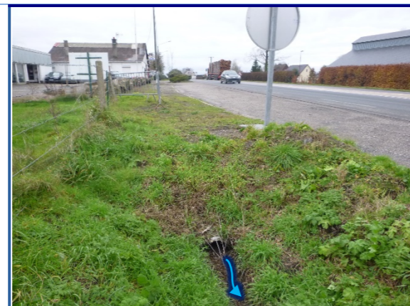
Busage Ø300mm à l'amont du fossé
